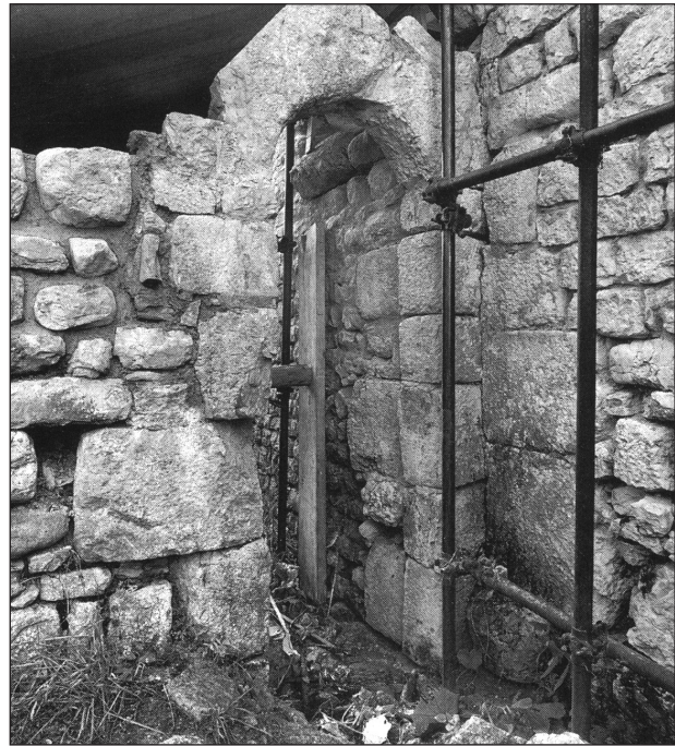
Fig. 3 Chartreuse d'Oujon. Entrée dans la ruelle des convers, côté réfectoire (V sur le plan). État durant les fouilles des années 1970, aujourd'hui enfoui.
