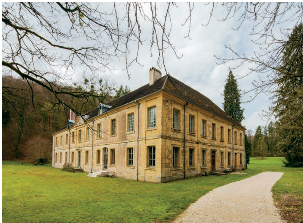
Angle sud-est du bâtiment conventuel, de 1786–1789. État actuel. Photo : auteur.
