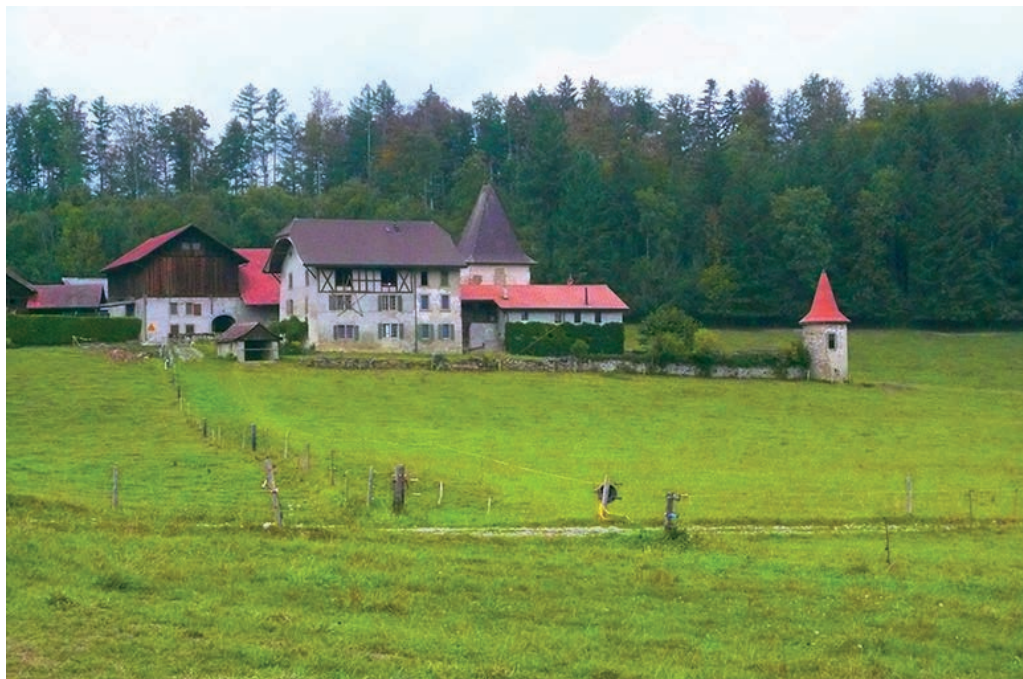
Fig. 6 : Le domaine de la Dausaz, ancienne grange de Hautcrêt. Photo: auteur
