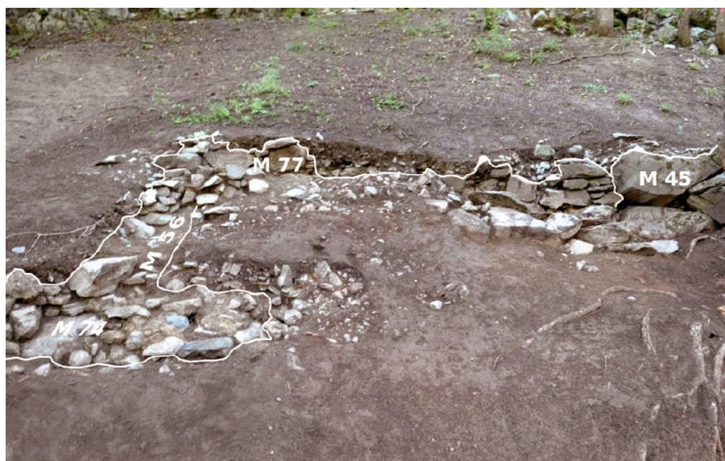
Fig. 6. Pièce orientale du bâtiment B13 ayant peut-être servi de chœur pour la probable chapelle. Vue est. Photo UNIL-IASA.
